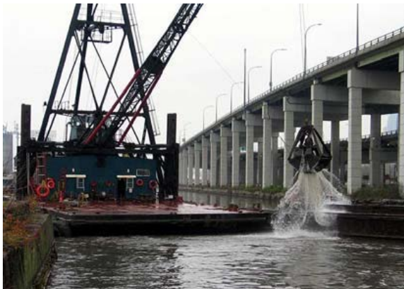
کلامشل در حال عملیات لایروبی
