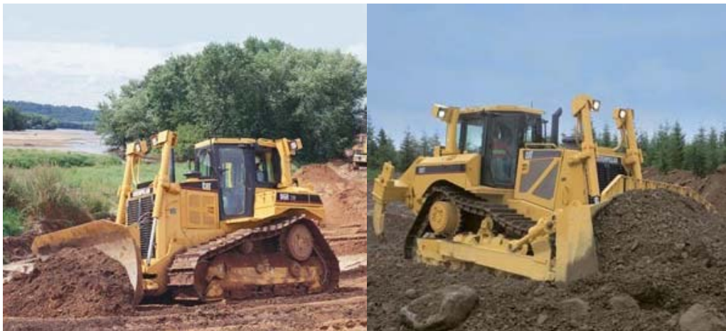
بولدوزر در حین عملیات خاکی
