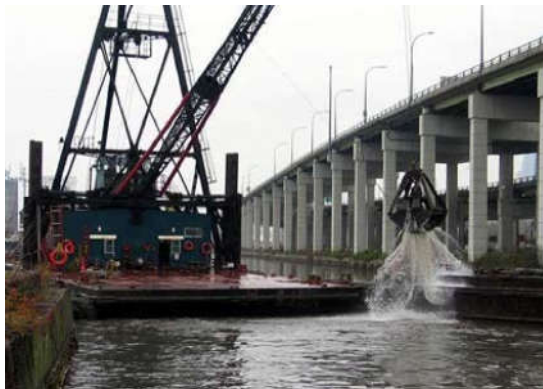
کلامشل در حال عملیات لایروبی
