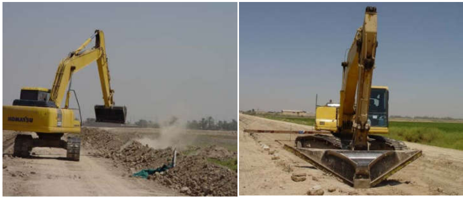
(الف) بیل برای زاویه دادن به کانال‌های بزرگ (ب) بیل دوزنق‌های برای حفر کانال‌های کوچک
